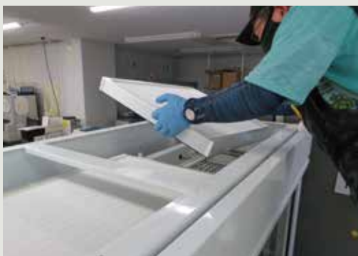
HEPAフィルターの交換点検
