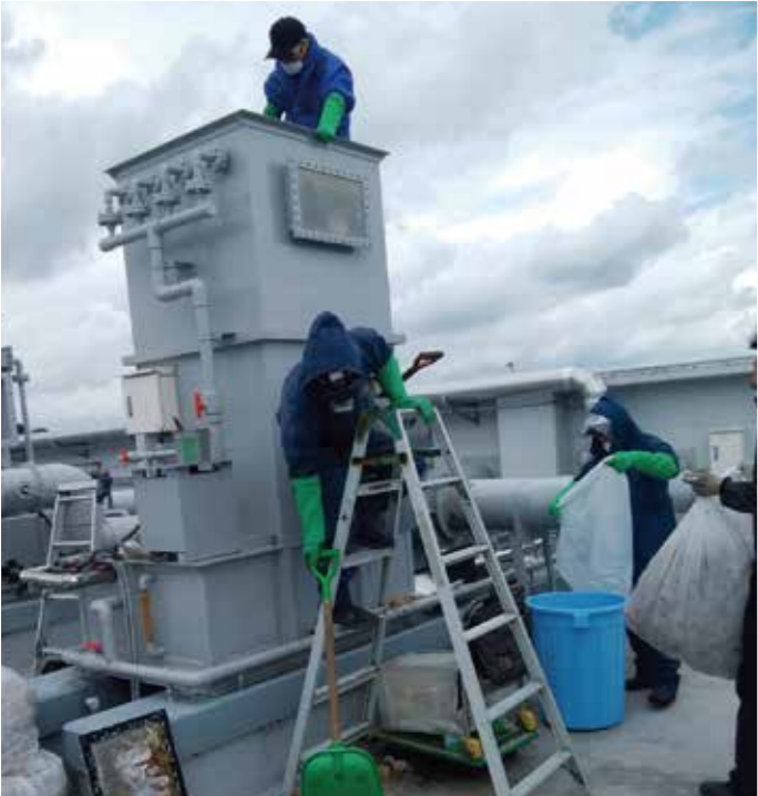
使用済み充填材 交換作業
