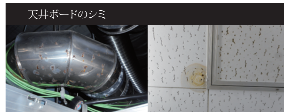
天井内ダクトの腐蝕
