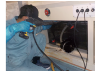
ドラフトチャンバー内蔵循環タンク洗浄
