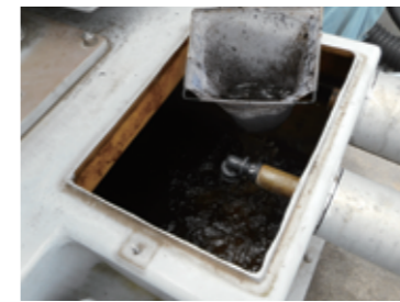
タンク内沈殿物除去
