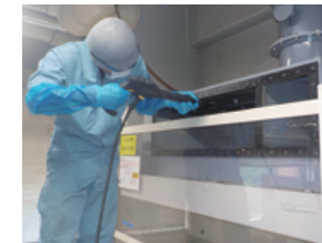
ドラフトチャンバー搭載スクラバー洗浄
