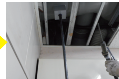
ダクト内液化不純物回収ドレンパイプ取付け
